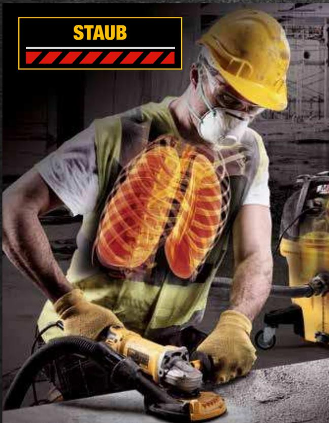
Schwebstaub schädigt die Atemwege. Effiziente Absaugsysteme wie SDS-plus® Absaugbohrer oder M-/H-Klasse-Sauger mit automatischer Filterreinigung minimieren die Staubbelastung deutlich.
